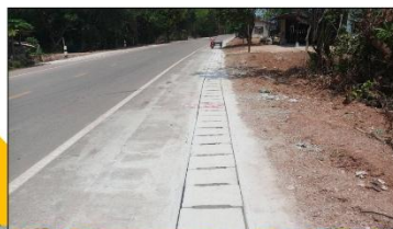
ออกแบบรางระบายน้ำด้านข้างในช่วงที่มีผลต่อการไหลของน้ำ
